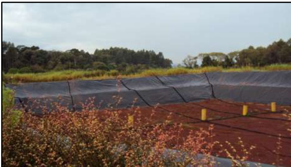
Figura 50: Célula preparada para recebimento de Resíduos
