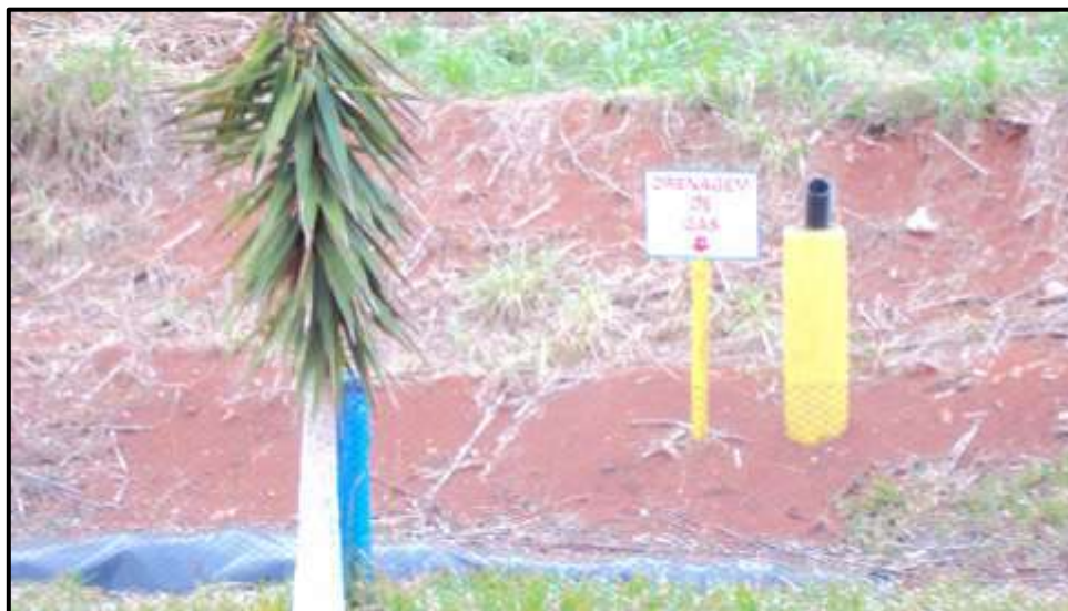
Figura 53: Sistema de drenagem de gás.
