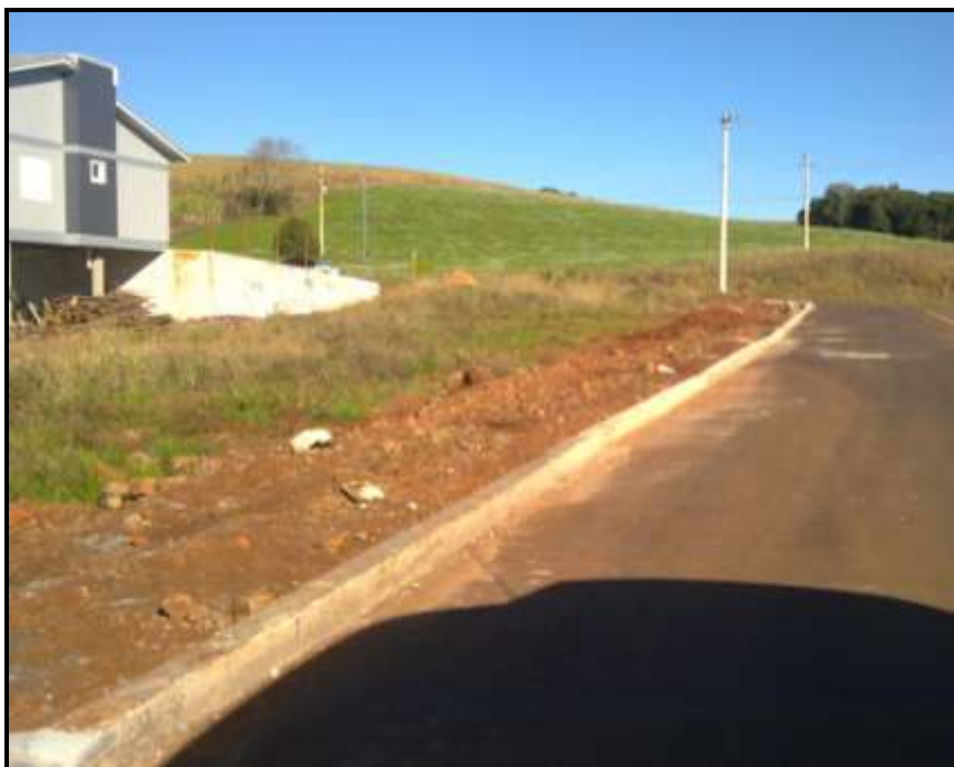
Figura 31: Sarjeta e meio fio
