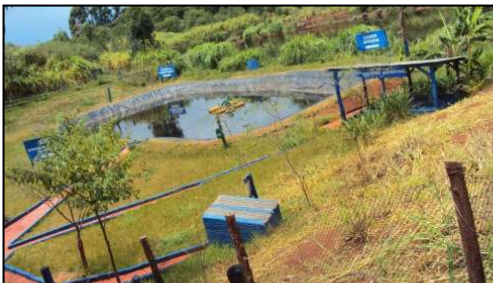
Figura 24: Lagoa aerada na ETE da empresa SIMPEX
