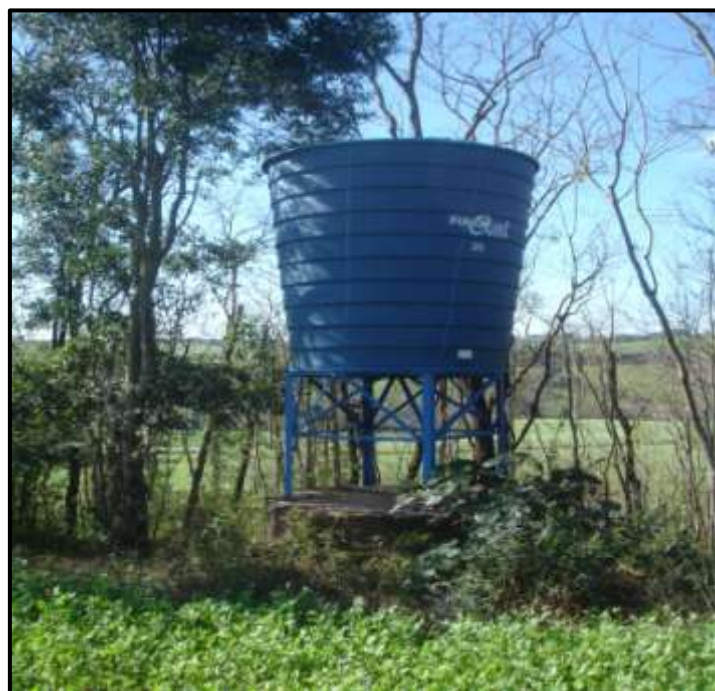
Figura 24: Reservatório – Linha Santa Lúcia
