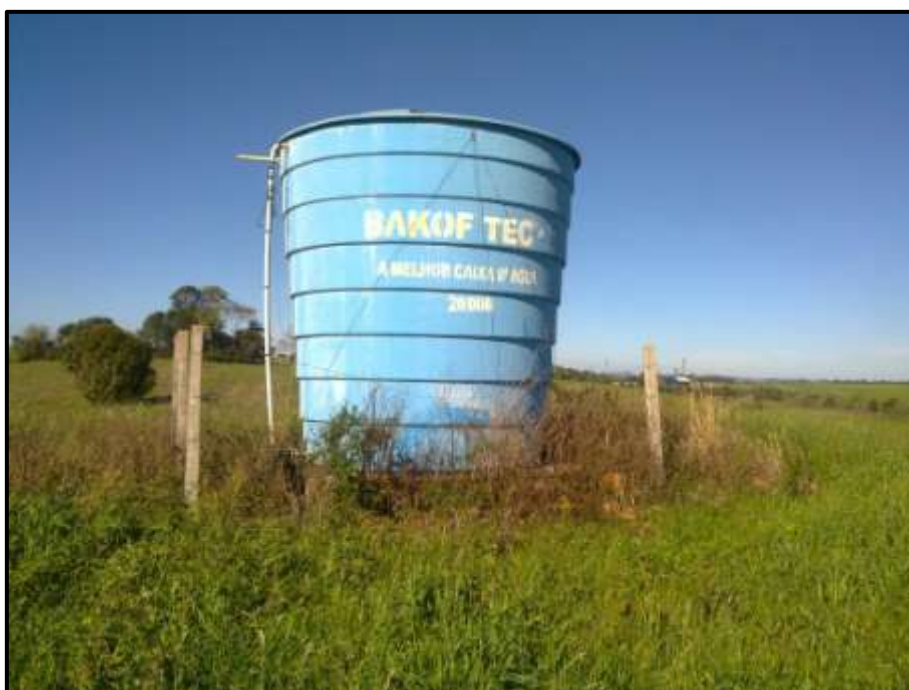
Figura 26: Reservatório – Linha Encantado
