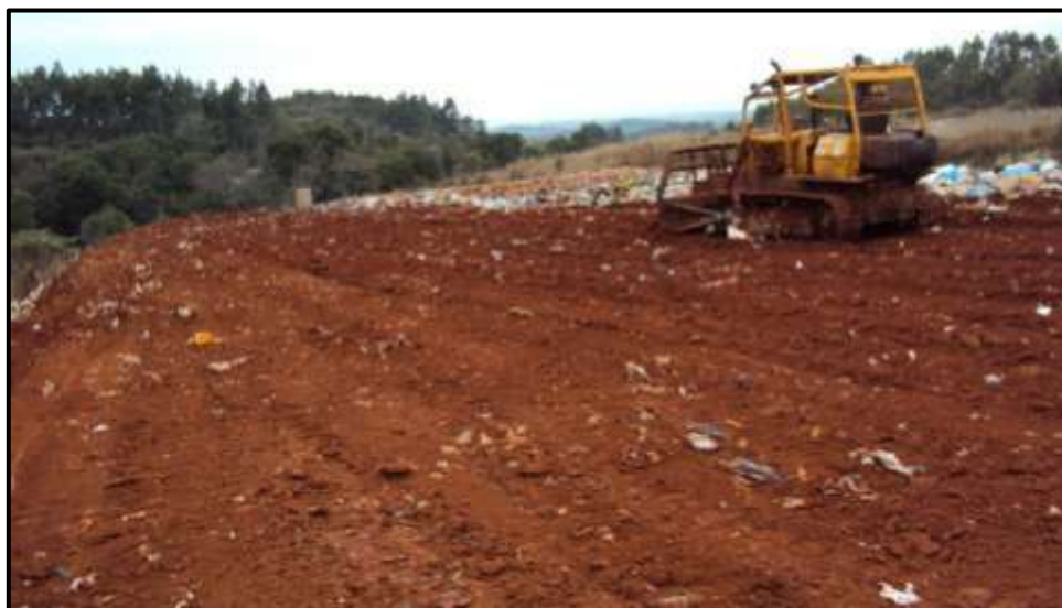
Figura 52: Compactação de Resíduos na célula .
