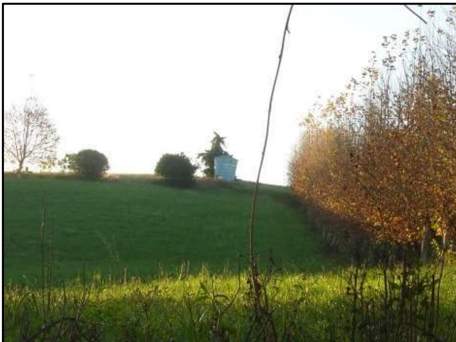
Figura 30: Reservatório – Linha Carijó I
