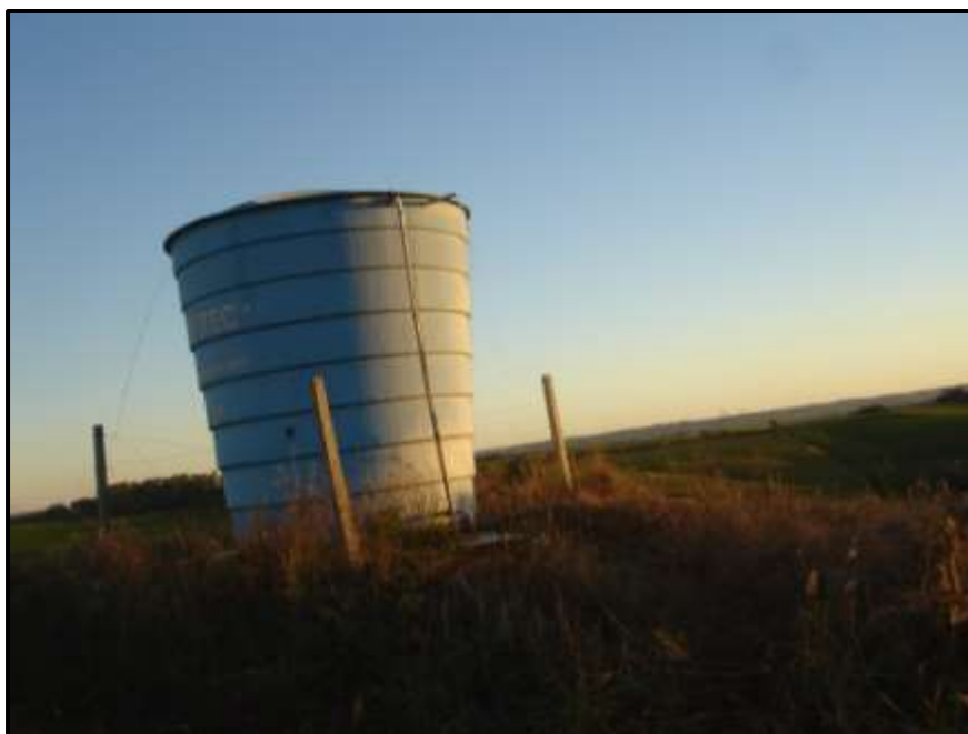
Figura 33: Reservatório – Linha Carijó II
