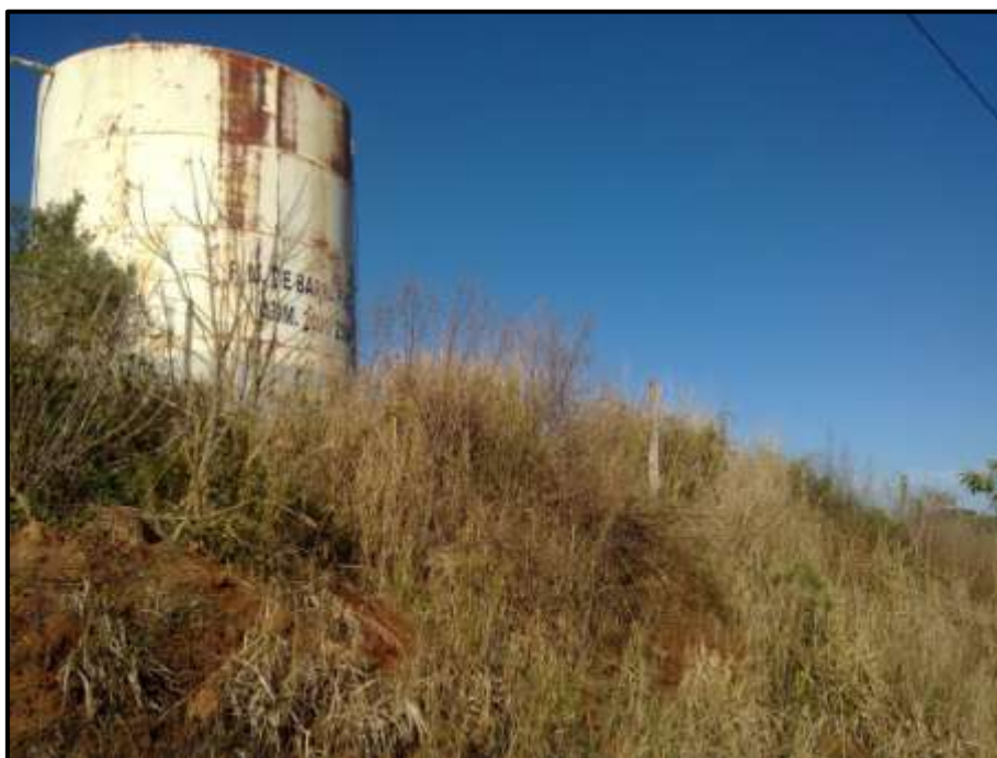
Figura 22: Reservatório da Linha Encantado – Abastecimento Sede
