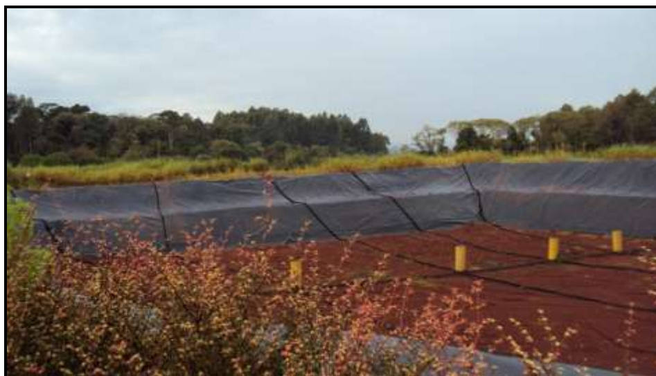
Figura 17: Célula preparada para recebimento de Resíduos
