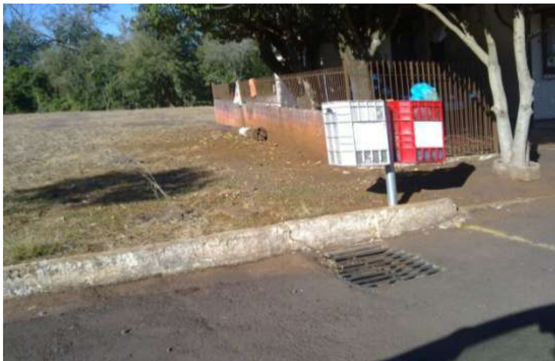
Figura 32: Caixa Coletora com gradeamento
