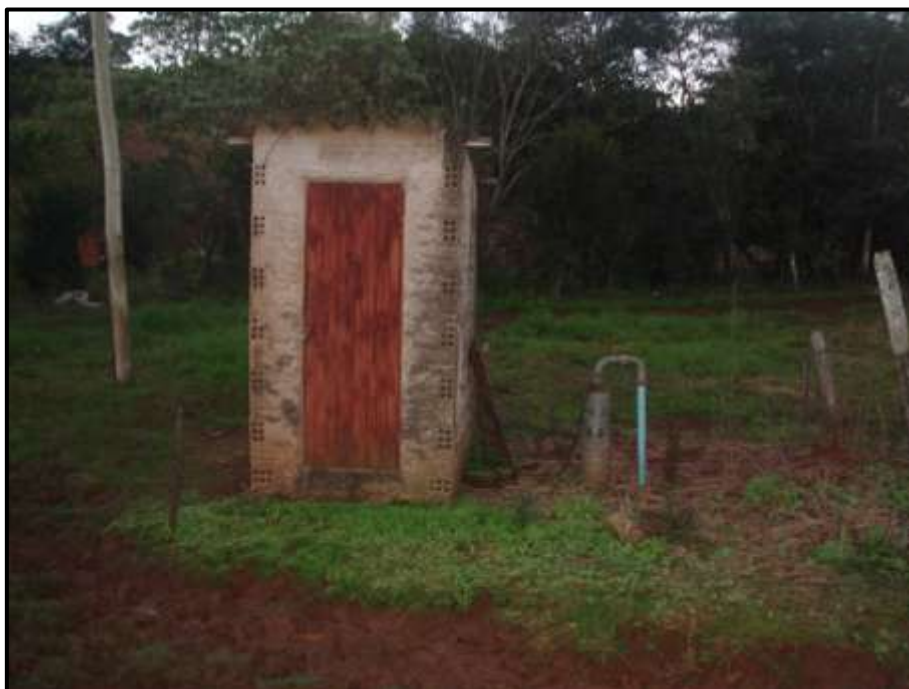
Figura 27: Poço Artesiano – Linha Cabrito
