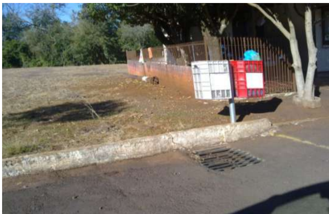
Figura 66: Caixa Coletora com gradeamento
