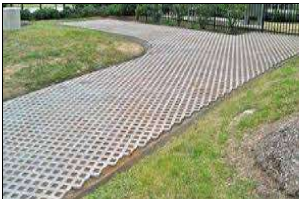
Figura 34 : Revestimento com Paivers nos passeios públicos
