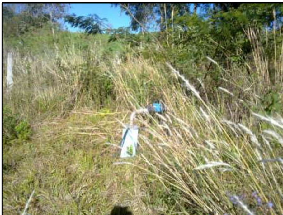
Figura 25: Poço Artesiano – Linha Encantado
