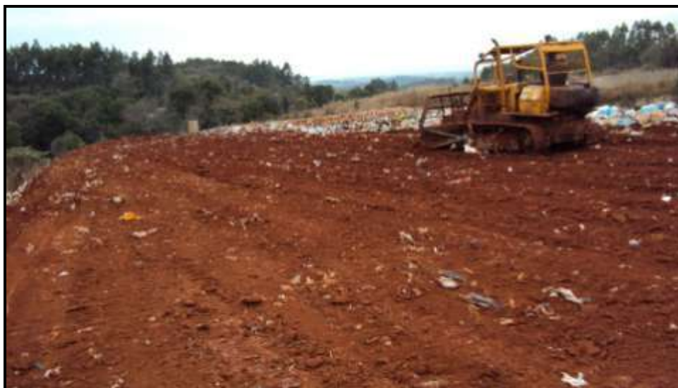
Figura 19: Compactação de Resíduos na célula .
