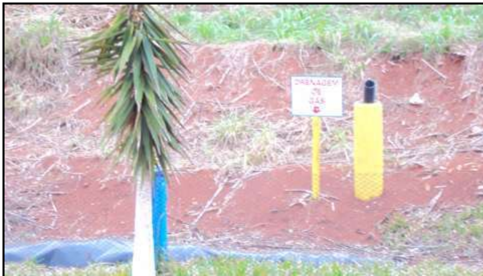
Figura 20: Sistema de drenagem de gás.
