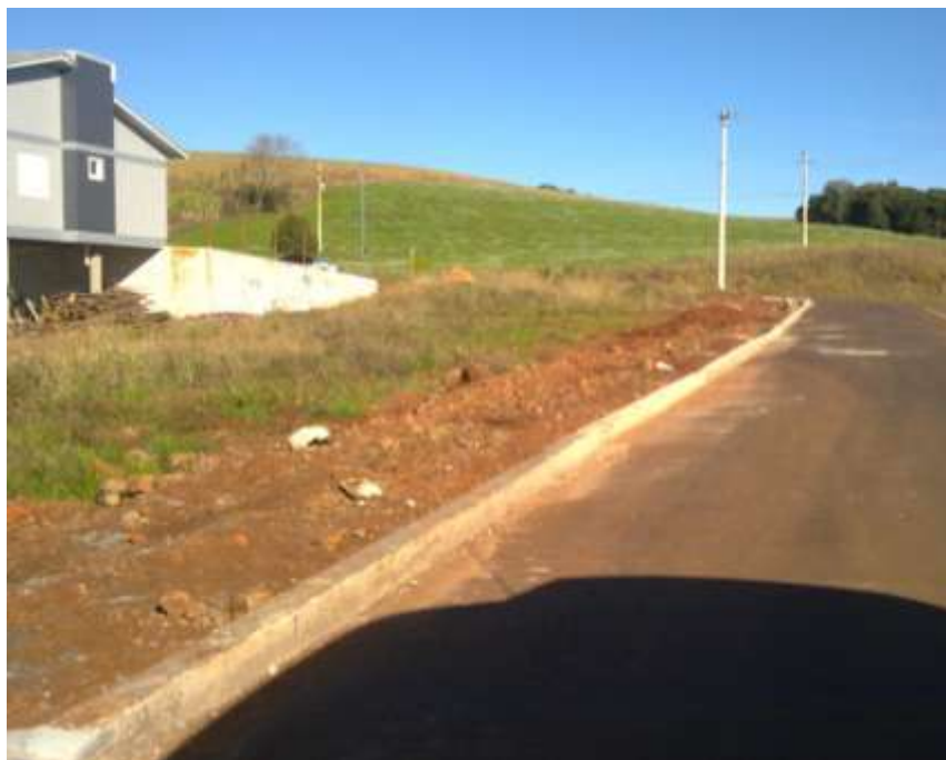
Figura 65: Sarjeta e meio fio
