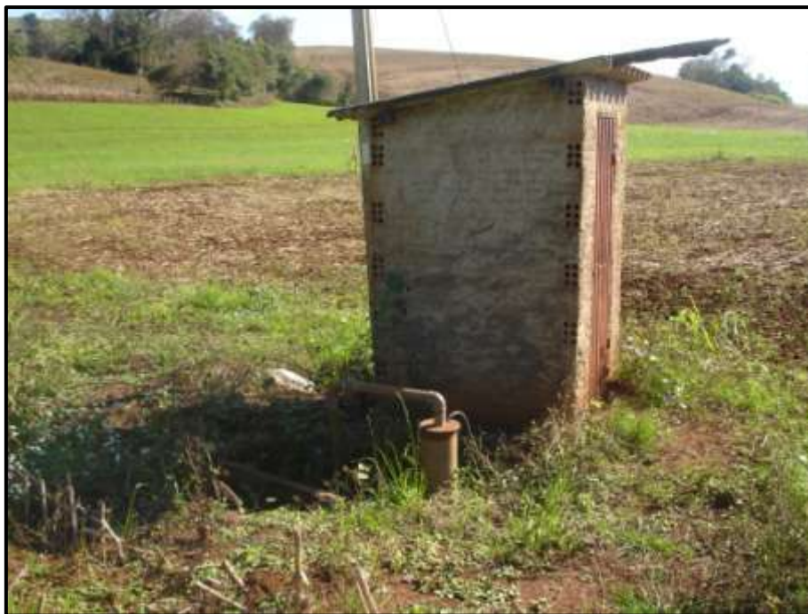
Figura 23: Poço Artesiano – Linha Santa Lúcia
