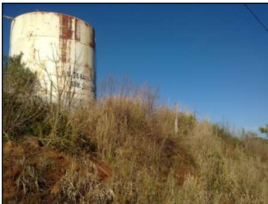
Figura 10: Reservatório da Linha Encantado – Abastecimento Sede
